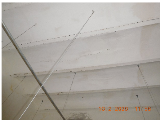
Imagen 1: Vista losa bóveda catalana fisurada área de la Sala de ministros.
