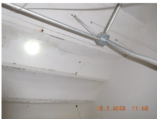
Imagen 3: Vista losa bóveda catalana fisurada área de la Sala de ministros.
