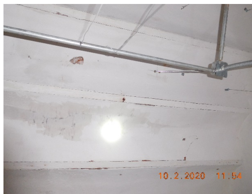
Imagen 2: Vista losa bóveda catalana fisurada área de la Sala de ministros.
