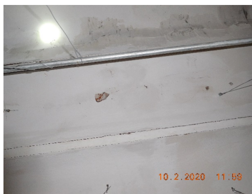
Imagen 4: Vista losa bóveda catalana fisurada área de la Sala de ministros.
