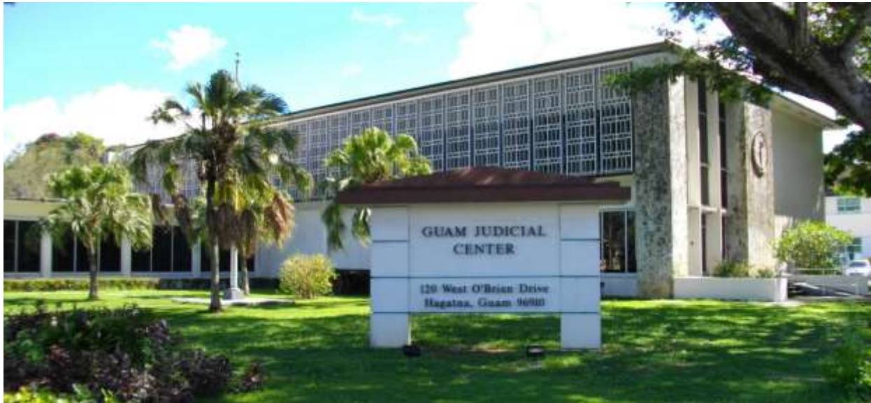
Guam, Centro Judicial (La Suprema Corte está en el 3er piso)
