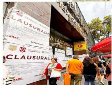
El Instituto de Verificación Administrativa (Invea) clausuró ayer la plaza "México Mart" de 16 pisos.
