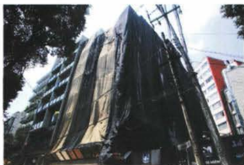
ESTE EDIFICIO en la calle de Chilpancingo sigue en reconstrucción.
