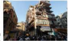
UN EDIFICIO en ruinas tras un ataque israelí en el sur de Beirut.
